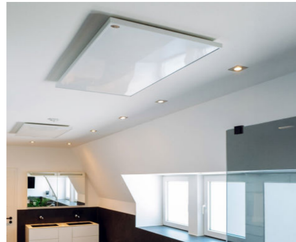
Plafondverwarming in de badkamer.
